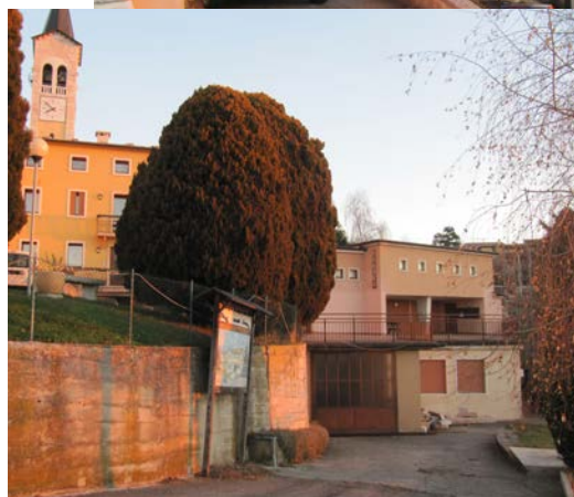
L'accesso al Centro giovanile e alla futura autorimessa
